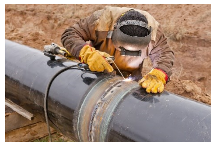
Les faisceaux de neutrons ont permis d'expliquer des problèmes de fissuration dans les pipelines vieillissants du Canada et d'établir des normes de fiabilité pour l'industrie.
