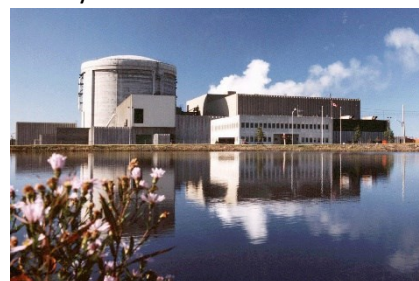
Les faisceaux de neutrons ont permis d'expliquer et de prévenir les temps d'arrêt causés par des fuites dans le parc de réacteurs nucléaires du Canada.
